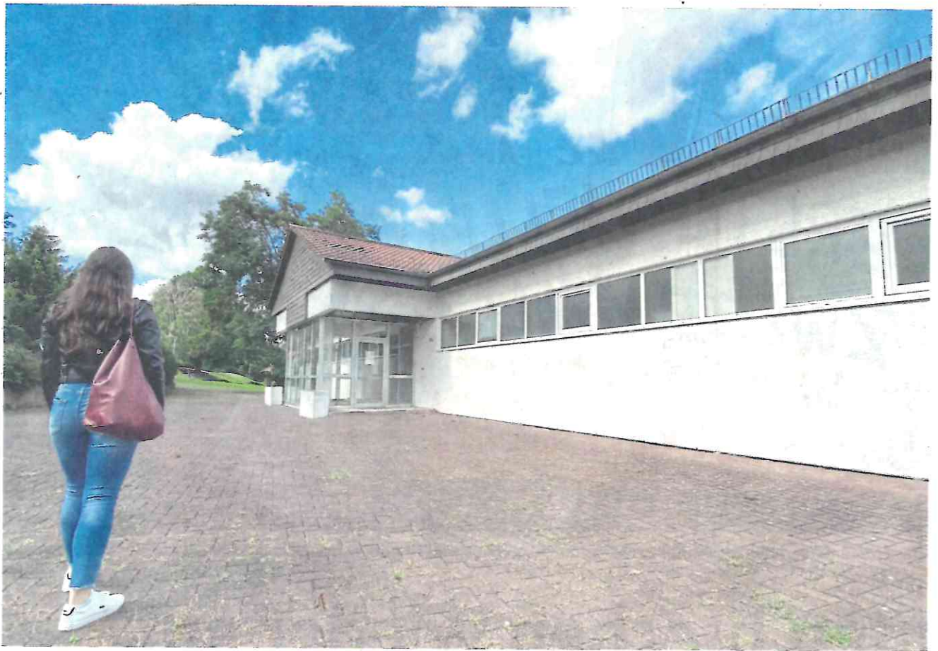
Soll Schule werden: Das ehemalige Zierenberger Schwimmbad wird derzeit vom Landkreis als Übergangslösung hergerichtet, weil im Frühling die Sanierungsarbeiten an der Elisabeth-Selbert-Schule starten.
